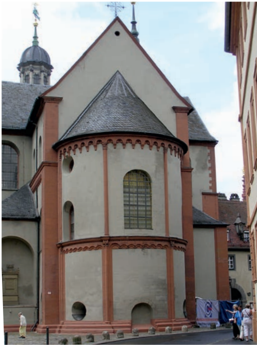
Abb. 21: Würzburg, Neumünster, Ostapsis, gefüllter Rundbogenfries
