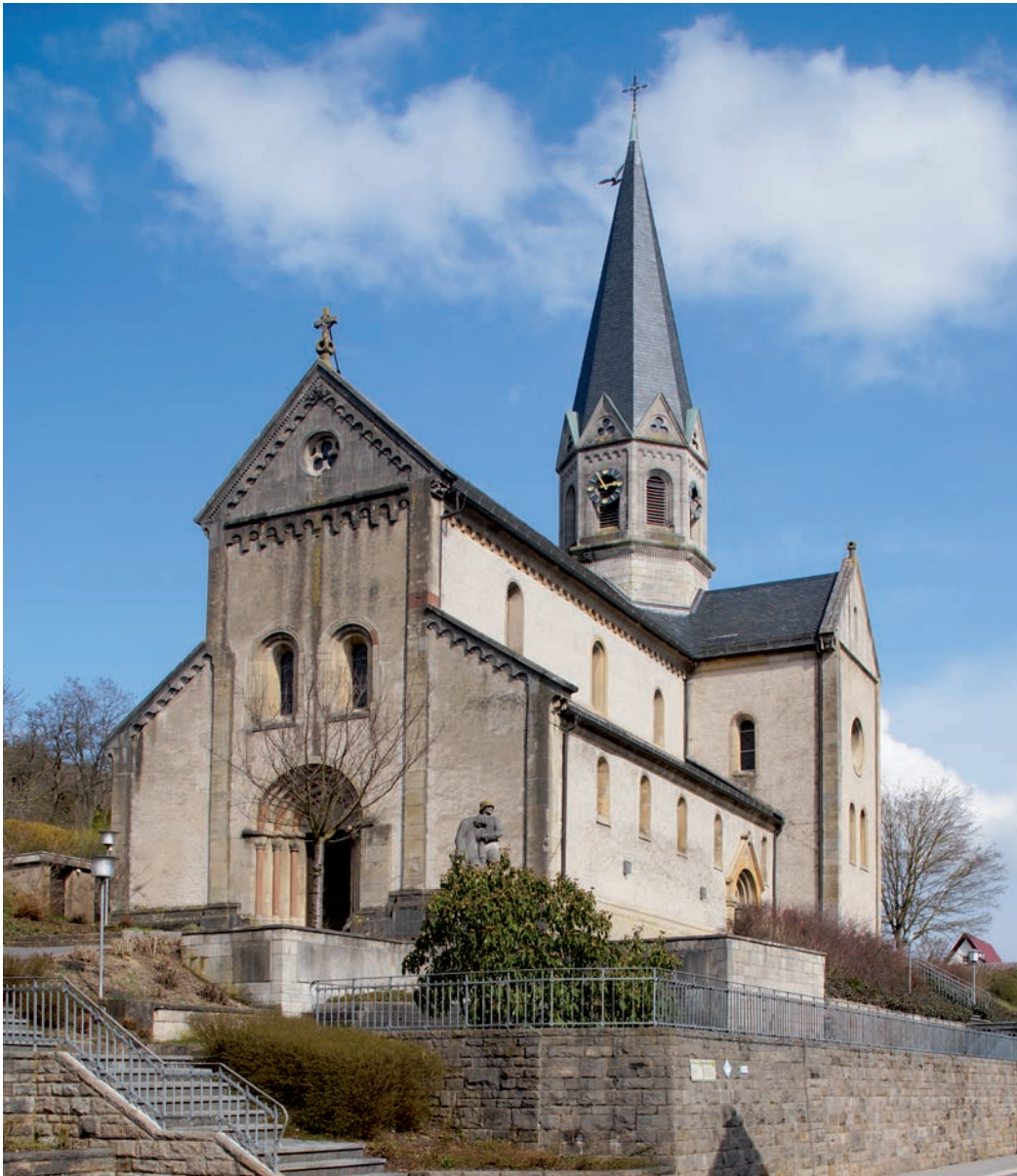
Abb. 17: Wölchingen, Johanniterkirche, Außenansicht (Foto: Verf.)
