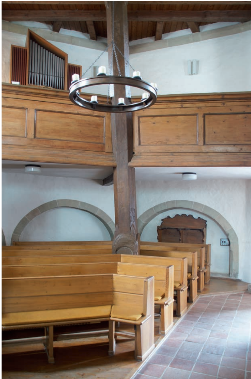
Abb. 13: Standorf, Ulrichskapelle, mittlerer Eichenstamm, aus der Mitte versetzt und in sich verzogen (Foto: Verf.)
