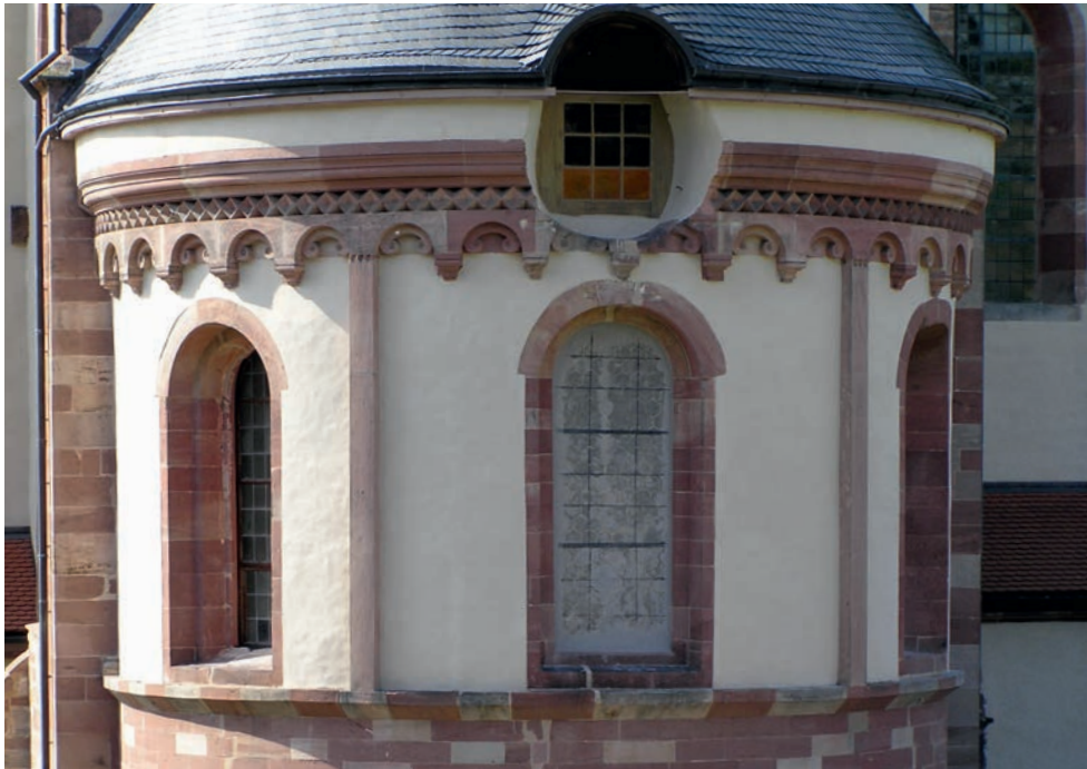
Abb. 19: Bronnbach, Hauptapsis, Diamant- und gefüllter Rundbogenfries
