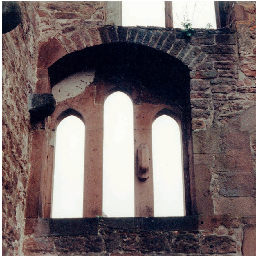
Abb. 13: Burg Wertheim, Dreierfenster mit Verschlussöffnungen in der Giebelseite im südlichen Wohnbau (Foto: Verf. 1997)
