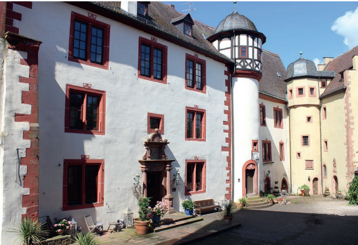
Abb. 2: Hofansicht Gamburg mit Eckquaderung aus der Erbauungszeit (Foto: G. von Mallinckrodt 2016)
