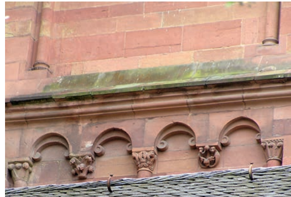
Abb. 20: Würzburg, Dom, Südturm, gefüllter Rundbogenfries
