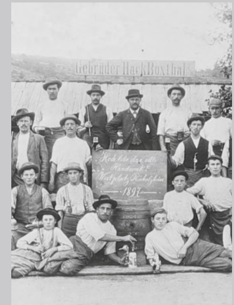
Steinbrucharbeiter des Steinbruchbetriebs Gebrüder Hack Boxtal am Werkplatz Reicholzheim, 1897. Aufnahme: Max Simon, Wertheim Vortage: LABW, StAWt-S-N 70 Nr. 46, Foto 2327/12
